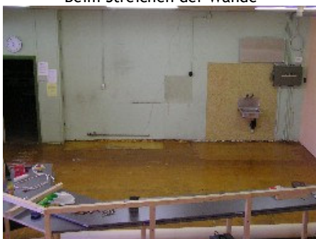
Der Bau einer Bar 3
